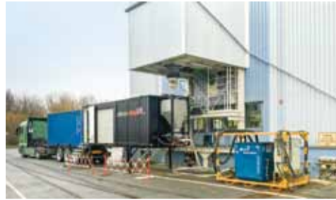
Der AERZEN Delta Blower sorgt als dezentrale Einheit für die Förderluft des Siloadmaxx-Systems.
