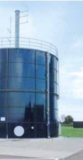
Der Gasspeicher hat ein Fassungsvermögen von ca. 500 m 3 .
