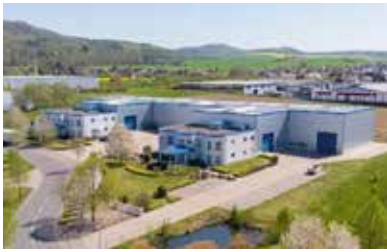
13.000 m 2 misst die Grundstücksfläche am neuen Standort von Aerzen Turbo Europe.
