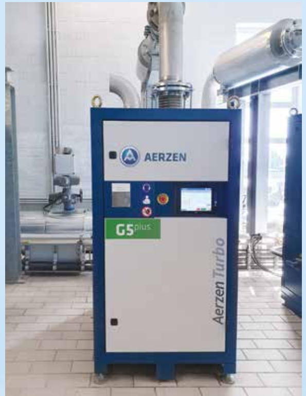
Die Turbogebläse der Baureihe G5 plus gehören zu den kompaktesten und effizientesten Turbos ihrer Klasse.
